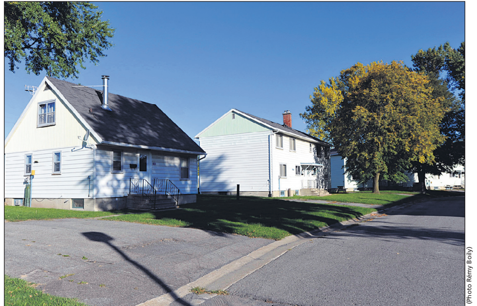
Les maisons de bois qui ont déjà servi à loger les familles de militaires seront démolies en 2012.
